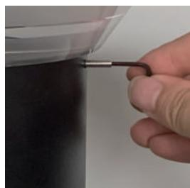
Utilisez la clé Allen pour serrer correctement les trois vis de réglage pour fixer la tête de lampe solaire sur le pilier en bon état.
